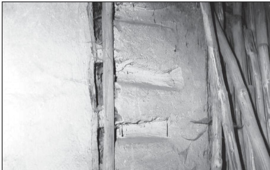
Obr. 2 Malé Březno čp. 11 (okr. Ústí nad Labem), teplovzdušná dvoukomorová sušárna. Sušící komora - kapsy pro uchycení vodících tyčí pro nesení lísek (v každé řadě jsou dvě za sebou). Foto František Ledvinka, 1982.
