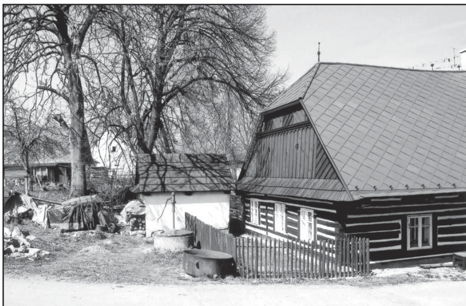
Obr. 3 Dřevíkov (okr. Chrudim), flusárna u domu čp. 47. Dnešní stav, v popředí kotel na odpařování draslářského louhu. Foto Jiří Woitsch 2003.
