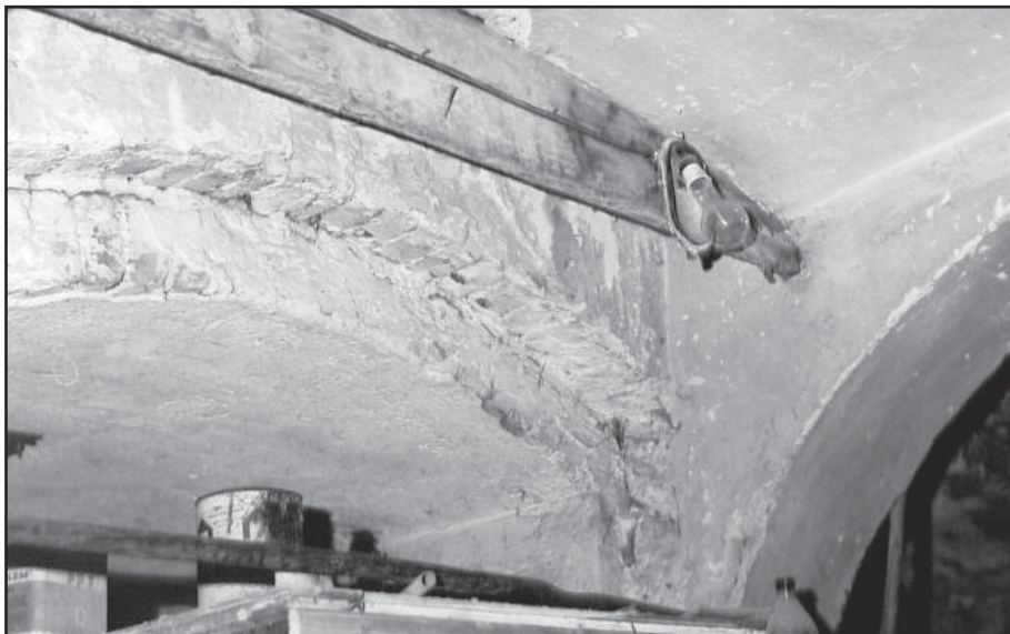
Obr. 5 Malé Březno čp. 11 (okr. Ústí nad Labem), teplovzdušná dvoukomorová sušárna. Před sušící komorou nahoře odsávací štěrбина s dřevěnou plentou. Foto František Ledvinka, 1982.
