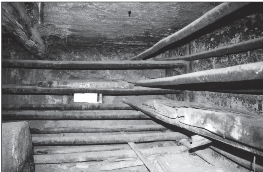
Obr. 3 Horní Lochov (okr. Jičín), sušárna ovoce s vynášecími lísami. Vlevo dole je vidět část tělesa vyhřívací pece, uprostřed nad okénkem a vpravo krátké vynášecí lisy. Foto Jan Pešta, 2002.
