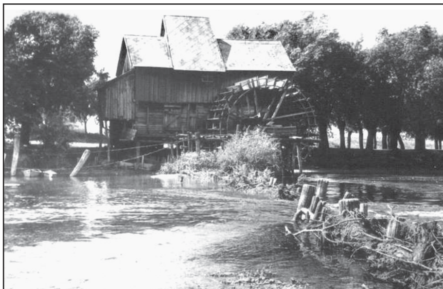
Obr. 8 Kolový mlyn na Malom Dunaji v Jelke, stav pred rekonštrukciou okolo roku 1983. V popredí vidno zvyšky hate. Foto Archív Krajského pamiatkového úradu v Tnave.
