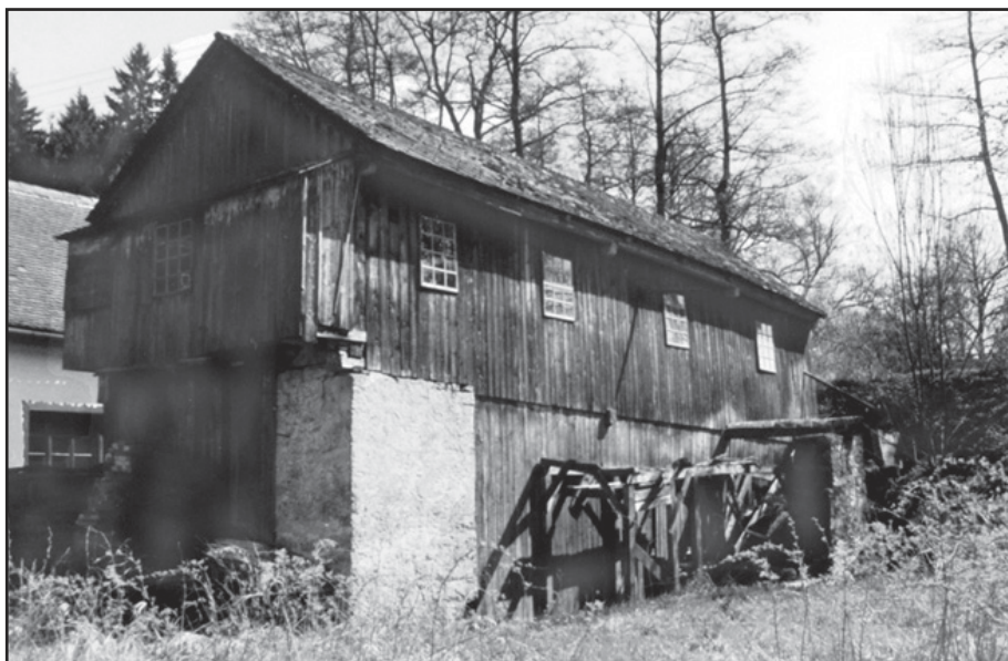
Obr. 1 Pohled na budovu pily z louky pod hrází rybníka. Podél budovy jsou zbytky náhonu a vodních kol. Stav před začátkem obnovy. Foto Karel Janák, 2001.
