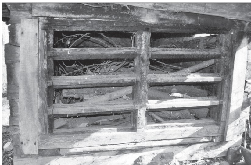
Obr. 5 Zálší (okr. Ústí nad Orlicí), sušárna ovoce s vynášecími lísami u domu čp. 12. Pohled na tzv. tahy pro lisy. Foto Radim Urbánek, 2001.
