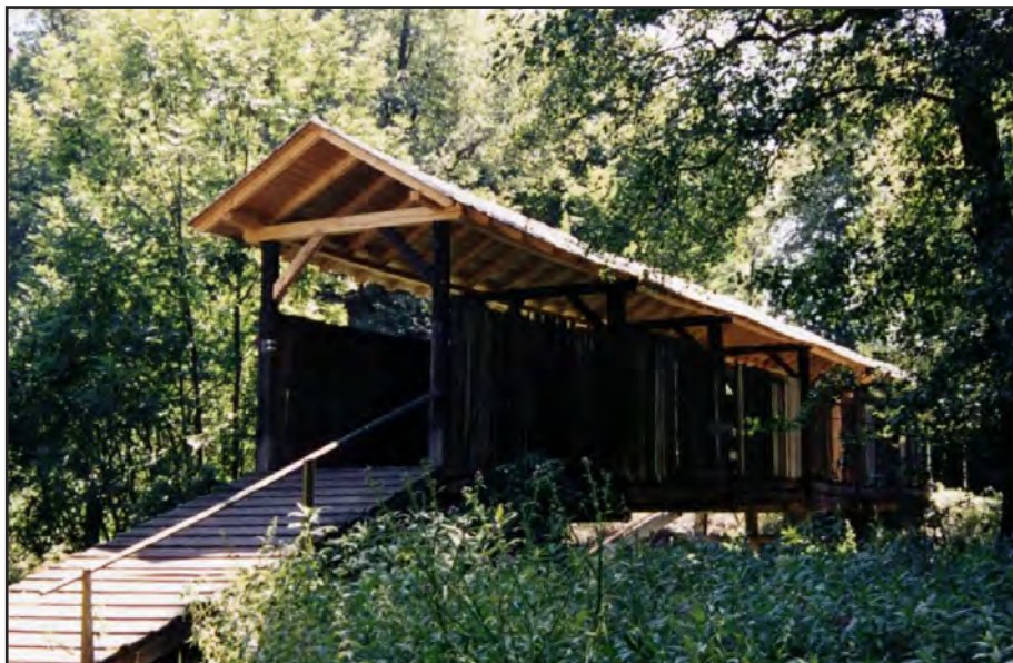
Obr. 3 Krytá dřevěná lávka přes Svratku na Prudké. Současný stav. Foto M. Válka 2003.
