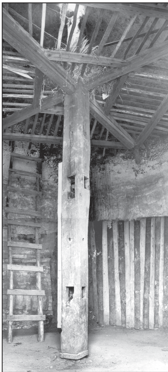
Obr. 6 Trstěnice, okr. Svitavy. Válcové sušičí prostory manufakturní pazderny. Stav v roce 1985. Foto M. Plecháčková, 1985.
