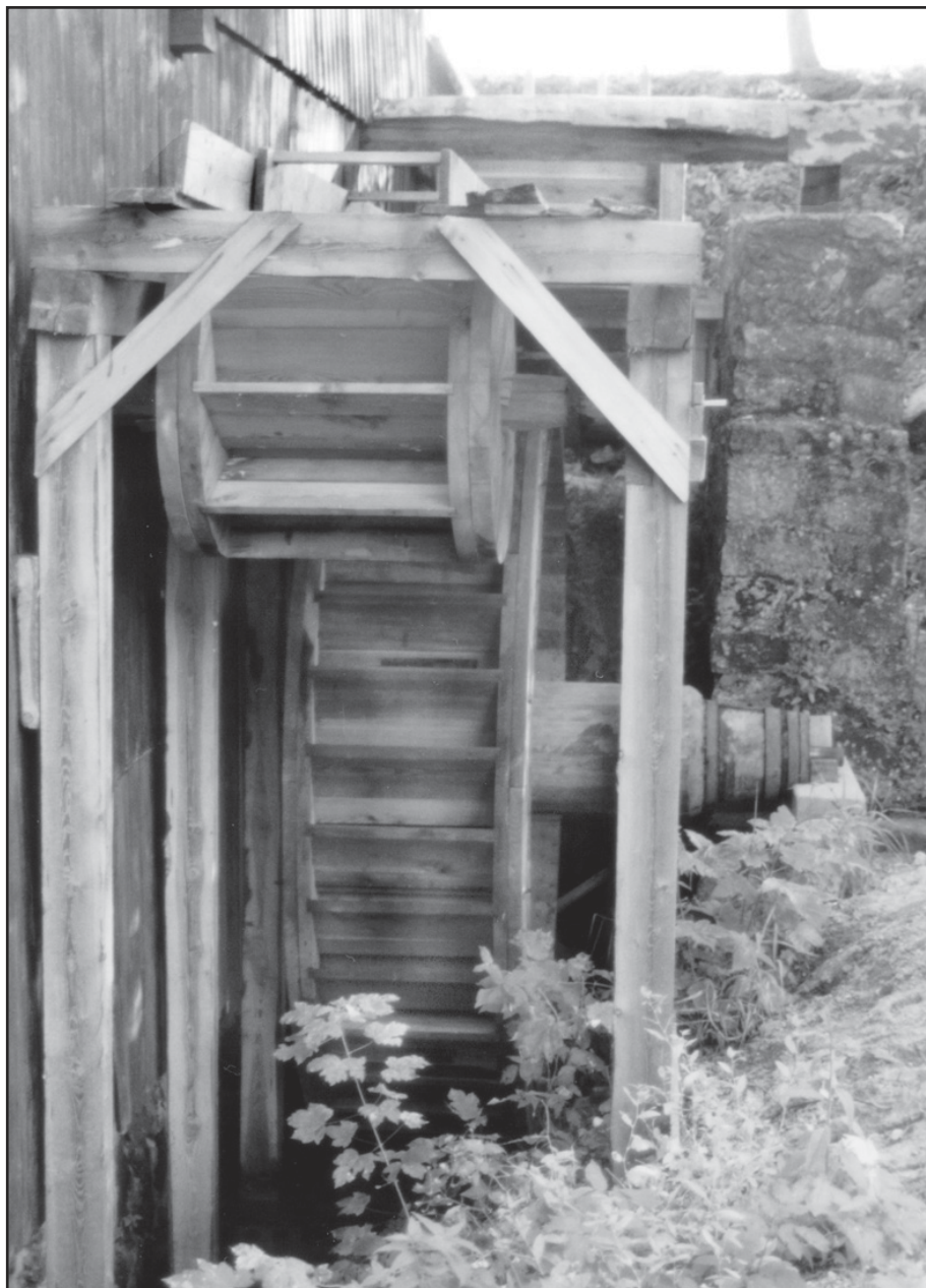
Obr. 6 Vodní kola a náhon po obnově. Stav 19.7.2003. Foto Karel Janák.
