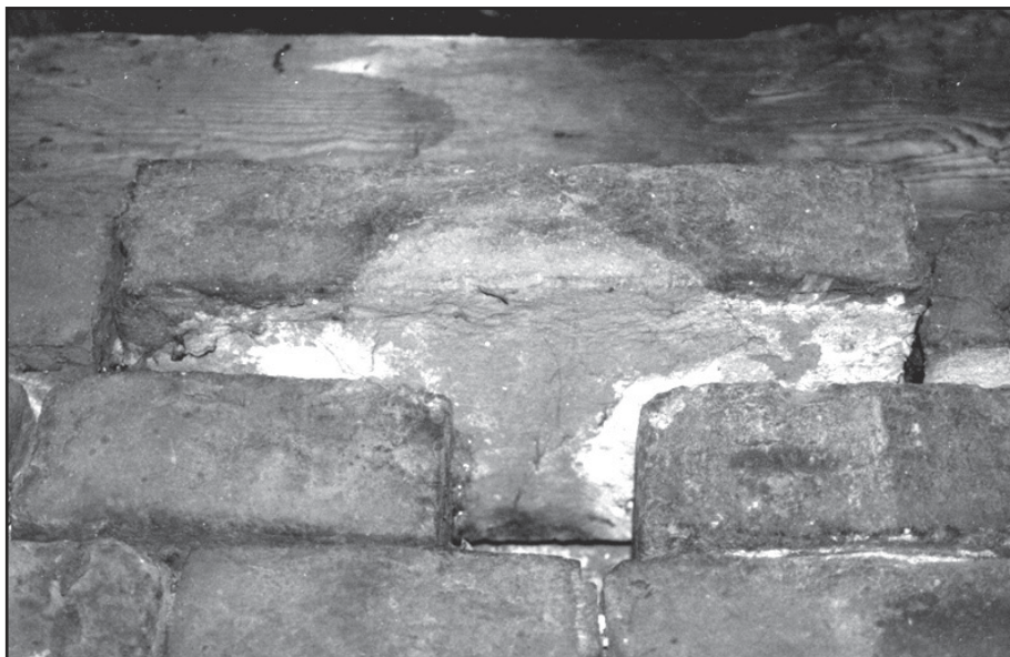
Obr. 10 Tisová (okr. Ústí nad Orlicí), sušárna ovoce u čp. 27. Přesazená cihla nad otvorem pro odvod odpařené vody. Foto Radim Urbánek, 2000.
