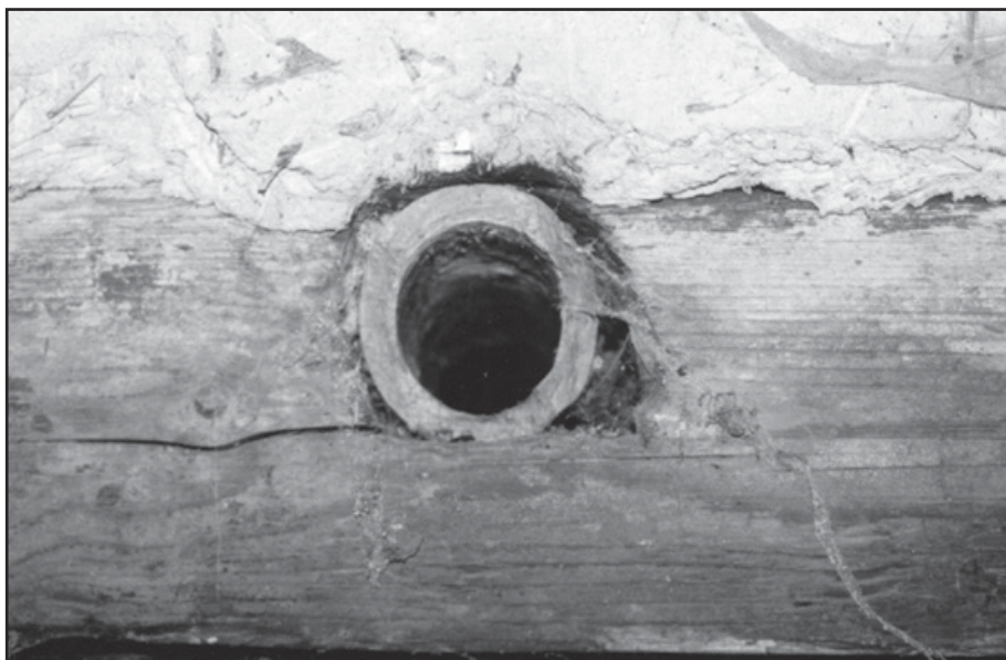
Obr. 11 Nořín (okr. Ústí nad Orlicí), sušárna ovoce u čp. 4. V nejvyšším trámu roubené sušící komory osazena keramická trubka pro odvod odpařené vody. Foto Radim Urbánek, 2000.
