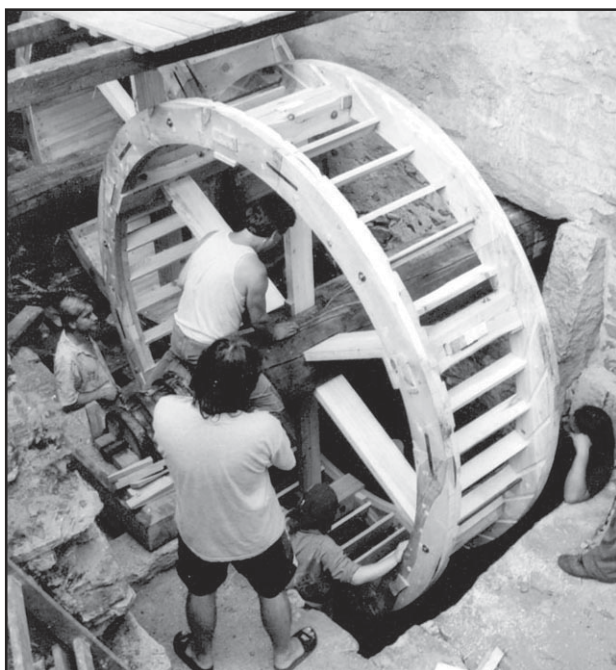
Obr. 4 Instalace druhého vodního kola v roce 2000. Foto Jiří Merta.
