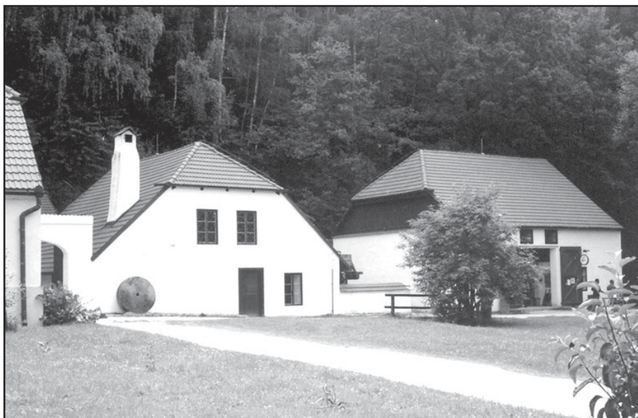
Obr. 7 Buškův hamr na Trhvosvínku (okr. České Budějovice) po rekonstrukci. Foto Zdeněk Rasl, 90. léta 20. století.
