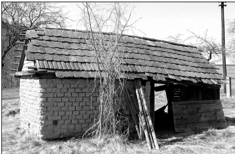
Obr. 8 Doly (okr. Chrudim), sušárna ovoce se zasouvacími lísami postavená z nepálených cihel. Foto Radim Urbánek, 2002.
