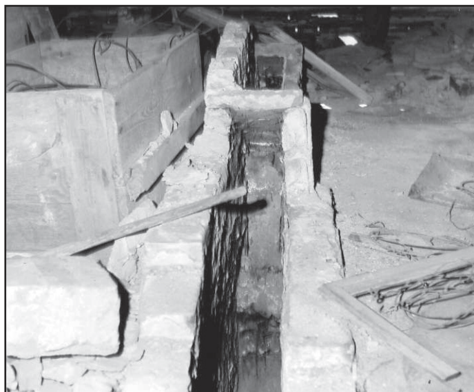
Obr. 3 Malé Březno čp. 11 (okr. Ústí nad Labem), teplovzdušná dvoukomorová sušárna. Odsávací štěrбина prostupující klenbou před komorou do půdního prostoru a odvedená do samostatného průduchu v komíně. Foto František Ledvinka, 1982.
