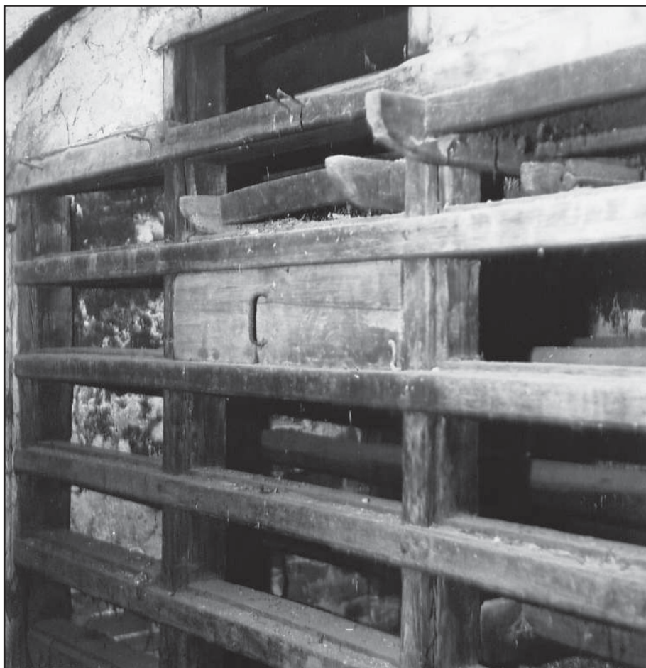
Obr. 1 Povrly čp. 6 (okr. Ústí nad Labem), teplovzdušná dvoukomorová sušárna. Uzavírací rám sušící komory. Horní otvor uprostřed slouží pro odvod výparů ze sušeného ovoce. Otvory se uzavírají samostatnými dvířky zapadajícími do horních a dolních žlábků. Foto František Ledvinka, 1977.
